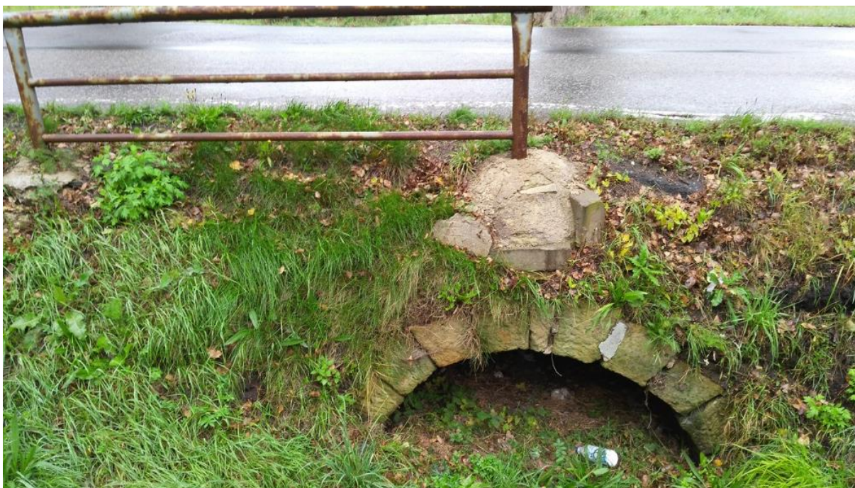
Propustek č.2 – pohled na výtok a zanesenou troubu
