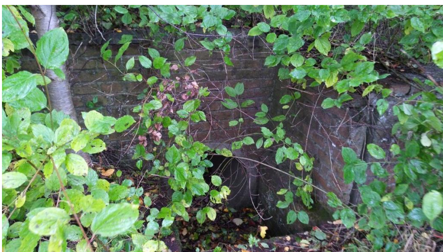
Propustek č. 4 – vtoková zděná jímka
