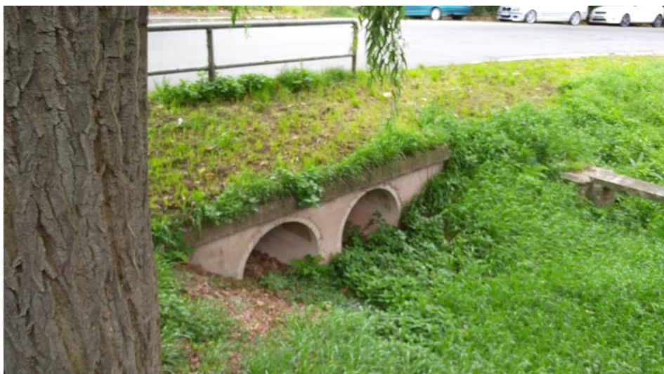
Propustek č.1 – pohled na výtokové čelo propustku
